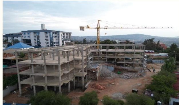
Lavori in corso – Centro di eccellenza oftalmologica Leonardo Del Vecchio, Kigali, Rwanda – dicembre 2023
